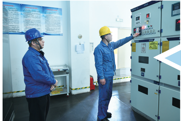
近日,设备修造厂启动电气设施春季检修及预防性试验,为全年供用电安全稳定运行筑牢根基。 刘娜 赵亚俊 摄影报道
