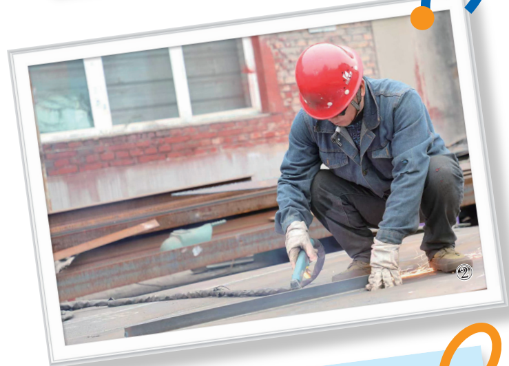
图①为营运分公司组织开展内燃机车冬季安全大检查,以严密举措保障煤炭运输安全畅通。(杨增光) 图②为工程建设公司将冬季“三防”安全培训的理论知识转化为一线施工的实操规范。(蔚乐)
