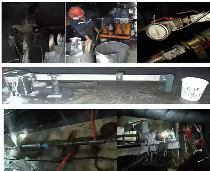
现场注浆液配比及注浆过程
