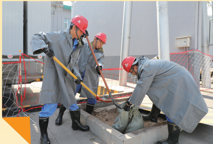
为切实提升应对突发汛情的应急处置能力,保障电力设施安全稳定运行,近日,供电分公司在变电站开展雨季“三防”实战演练。图为演练人员灌装沙袋阻止积水漫延。
