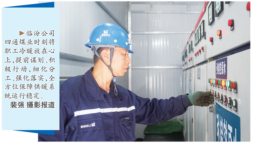
连日来,水峪煤业检修职工加班加点、紧锣密鼓地推进供暖各项工作,为冬季供暖设备的安全稳定运行筑起坚实防线。陈重凯 摄影报道
