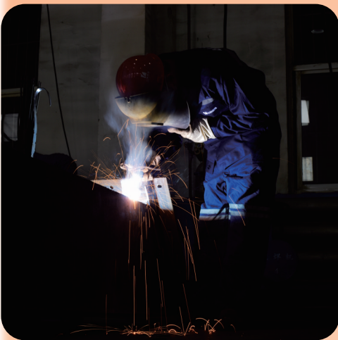
焊接 曙光煤矿 高翔 摄
