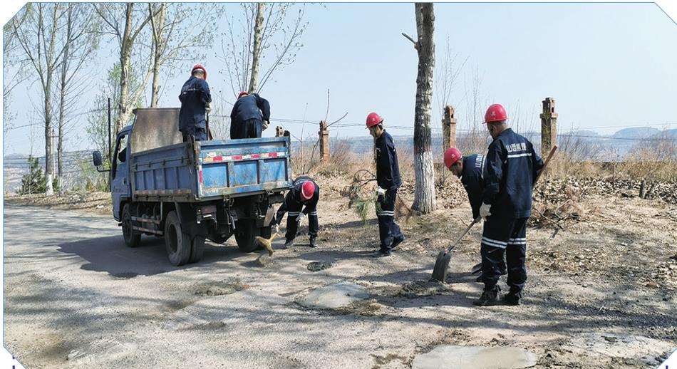
近日，宜兴煤业对矿区道路部分破损路段进行了修补，保证车辆通行顺畅。由于该公司出矿路段长期受雨水冲刷，导致路面低洼不平、破损严重、平整度下降、车辆行车颠簸，给职工出行带来安全隐患。为此，水暖队经过现场勘察，迅速开始了一场热火朝天的路面修补。大家有的挥舞铁锹填补混凝土，有的清理坑洼处的杂物，有的为填补的混凝土坑洼处设置警示牌。路面修补后，该公司员工开车上下班、外出办事都顺畅了许多，有效地保障了大家的出行安全。
