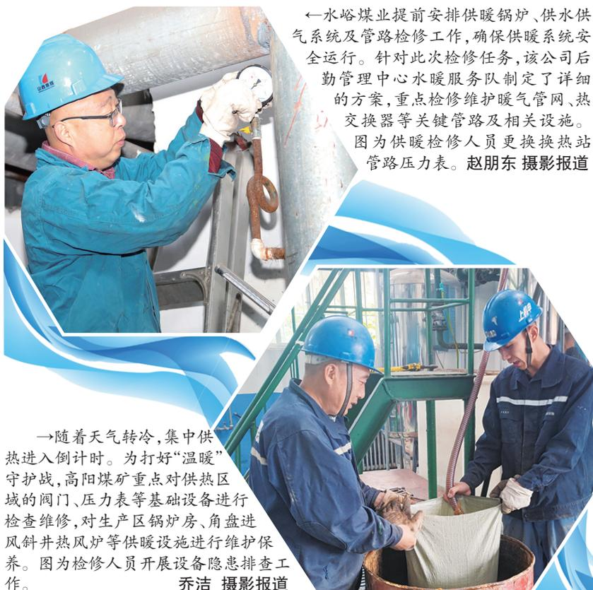
←水峪煤业提前安排供暖锅炉、供水供气系统及管路检修工作,确保供暖系统安全运行。针对此次检修任务,该公司后勤管理中心水暖服务队制定了详细的方案,重点检修维护暖气管网、热交换器等关键管路及相关设施。图为供暖检修人员更换换热站管路压力表。赵朋东 摄影报道
