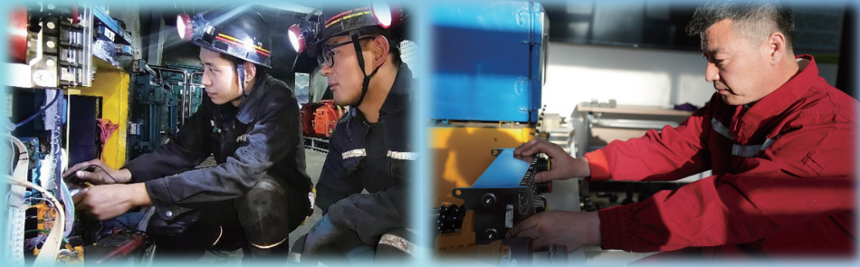
图为金辛达煤业“王仁利职工创新工作室”成员邢永强带领职工检修闸阀控制箱
