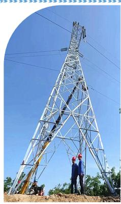
连续降雨过后,在北村II回线路特巡中,供用电分公司线路运维工区发现该线路4#塔四个塔腿主材向上弯曲变形,A、B腿基础下沉,铁塔整体向左侧倾斜,疑是采空区造成山体整体下沉。在该公司领导协调组织和各部门的应急抢险下,线路运维工区及时对输电线路进行了改造,保质保量完成了抢修工作,为夏季用电高峰期期间矿井安全稳定生产奠定了坚实基础。 付继红 那月芝 摄影报道
