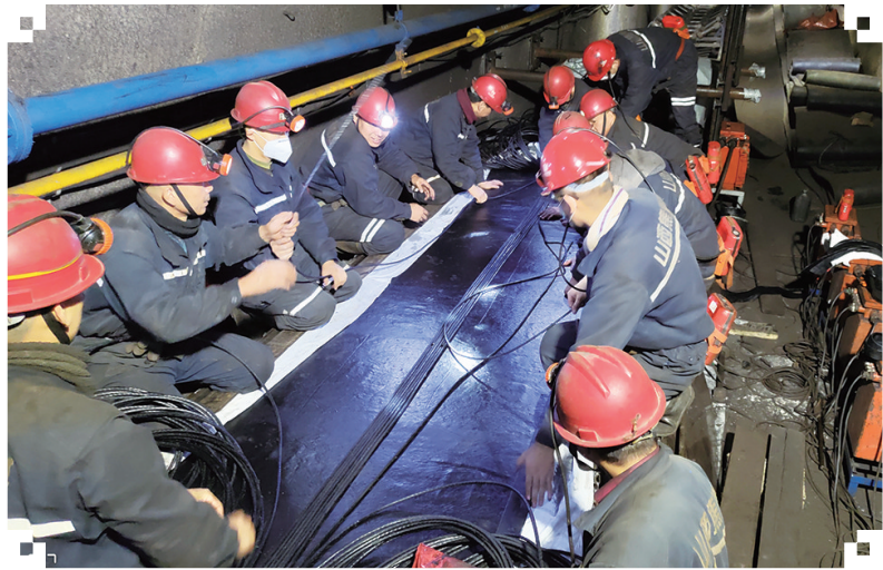
为把近3000米的皮带安全运输到位,近日,宜兴煤业领导带队深入现场了解施工进度,协调解决运输和硫化过程中出现的问题,基层管理人员加强跟班带班,现场解决技术难题,严格执行安全操作九条“红线”及行为治理等相关要求,一切行动听指挥,一切操作有规范,攻坚克难、并肩作战,顺利完成主斜井强力皮带更换任务。刘韬雍 摄影报道
