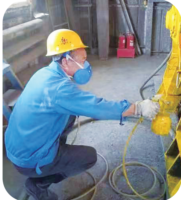
近日,工程建设公司商砼厂对搅拌机主机进行了内部粘贴的混凝土清除,利用电镐、气镐等工具将主轴、叶片及内壁的混凝土彻底清理,使内部各个部件光滑如新,转动轻松。同时,对搅拌机主机外观也进行了打磨、除锈、喷(刷)油漆,使主机外观焕然一新,整个机房清洁明亮,为职工更好地开展工作,营造良好环境。 陈慧芳 孙烈摄影报道
