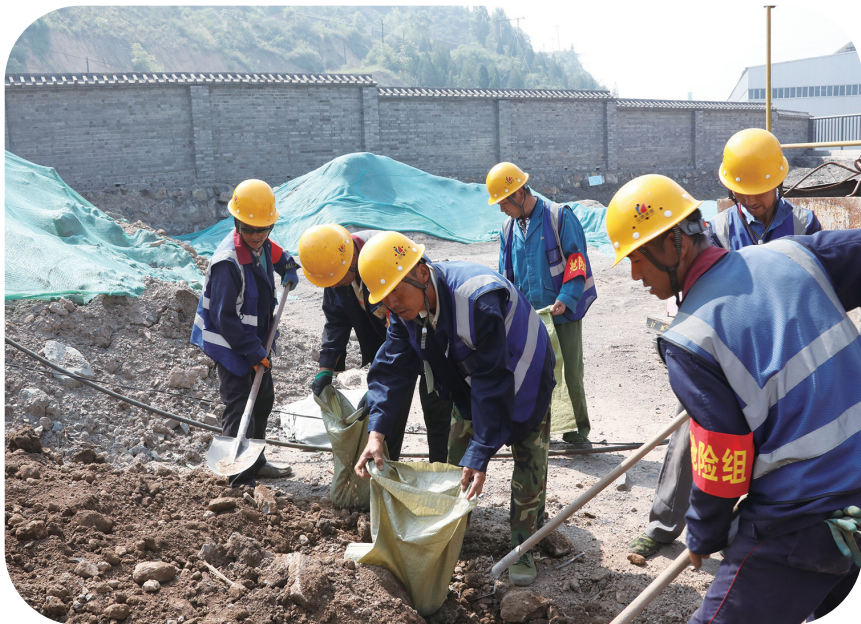
近日,工程建设公司在土建二部灵北施工工地开展雨季“三防”应急演练,模拟灵北施工工地突降暴雨,办公楼联建基坑出现雨水倒灌现象,随时有被淹塌方的危险。他们迅速启动雨季“三防”应急预案,抢险小分队迅速到位,根据应急预案展开救援。通过演练全面检验干部职工应急响应和处置能力、雨季“三防”应急预案的科学性和实用性,增强了全员应急抢险意识,提高了员工自救互救、妥善避灾的能力,为企业安全生产筑牢了“安全堤”。 张亮 王硕 摄影报道
