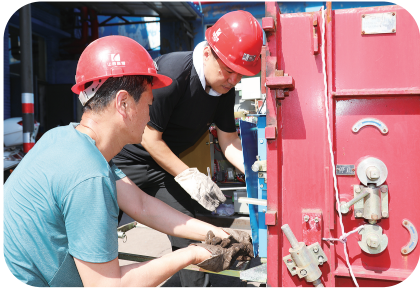
为了保证生产一线设备的正常运转,日前,水峪煤业下机电队机修组全体职工克服烈日炙烤、高温炎热的气候条件,将一台一台准备入井的隔爆开关详细检查,保障每台设备完好率、使用率、开机率达到100%。图为该公司下机电队机修组职工正在对隔爆开关进行检修。 李超 摄影报道
