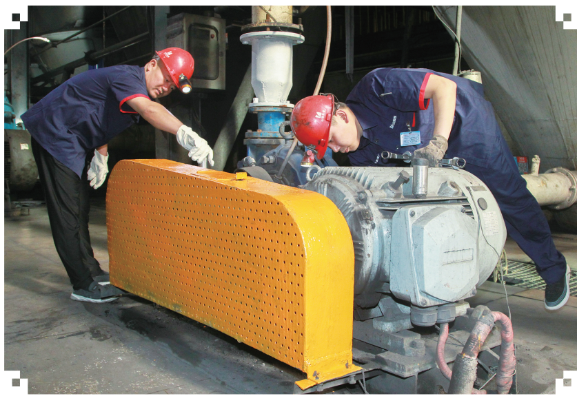
日前,曙光煤矿洗煤厂紧抓安全生产不放松,各车间、班组全面贯彻落实山西焦煤、集团公司下半年会议精神,加强安全监督检查,切实消除重大安全隐患,确保动态作业安全。他们制定检修计划,重点对设备易损件的预防性检查和更换,保证生产沿线设备完好,设备不“带病”运行,推进安全生产持续稳定。 闫建伟摄影报道
