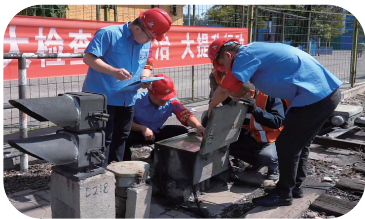
日前,营运分公司对专用线路防汛工作展开拉网式大排查,对线路运行区段因积水导致锈蚀、塌陷,以及线路两旁机电设施、设备运行和“三防”物资储备情况等问题逐项登记、制定措施、立即整改,严防各类灾害发生,确保煤炭调发运工作的安全有序运行。 耿婕 李雪摄影报道
