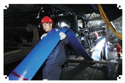
近日,柳湾煤矿数百名干部职工在煤场进行集结,对主井强力皮带机尾排水点强力排水泵所需的电缆及管路进行敷设,在吊车的协助下,分为多路将电缆向井下进行输送,电缆拖拽到位后,又开始投入到水管的敷设工作中。由于水管材质的特殊性,在操作过程中比电缆更加小心谨慎,从而增加了敷设难度。经过职工们肩扛手拖,忙碌了一上午,井下所有水管均已完成对接。
