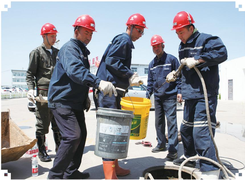
近日,宜兴煤业水暖队对公司生活用水蓄水池进行全面清洗,对池内相关气体测定合格后,施工人员佩戴齐全有效的劳动防护用品进入蓄水池对池底、池壁进行全面的冲洗,将淤泥上吊至地面倾倒。经过三个多小时的奋战,蓄水池被彻底清理干净。
