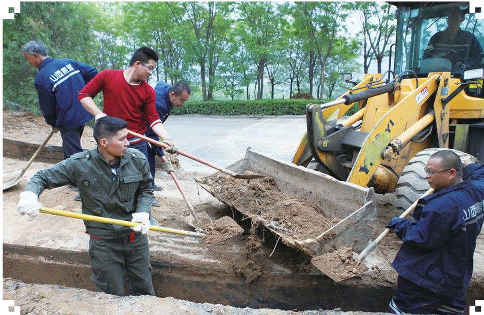
宜兴煤业加强雨季“三防”工作,做到早规划、早部署、早落实。后勤服务大队组织人员对停车场周边水泥地板裂缝进行灌浆封口、清理转运排水渠淤泥和杂物。针对下山凉亭山体滑坡导致局部排水沟渠堵塞问题,公司水暖队立即组织机械、人员进行抢修疏通,队组干部职工发扬不怕苦、不怕累的精神,保质保量地完成了此次任务,全力保障公司安全平稳度汛。
