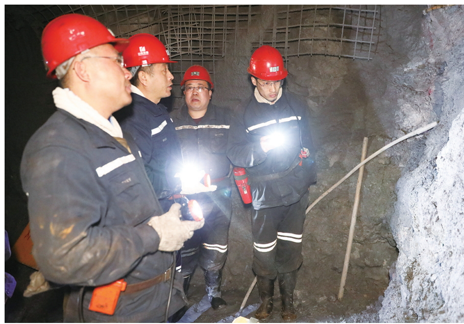
柳湾煤矿强化现场管理、提高站位、细化责任,加大对地面的巡查力度,深入排查生产中的风险隐患,防治灌井、山体滑坡、采空区涌水等现象,切实做好防水闭墙改造、四盘区泄水巷的推进、880大巷水沟浇筑等井下防排水系统改造工程有序进行,为安全度汛奠定坚实基础。
