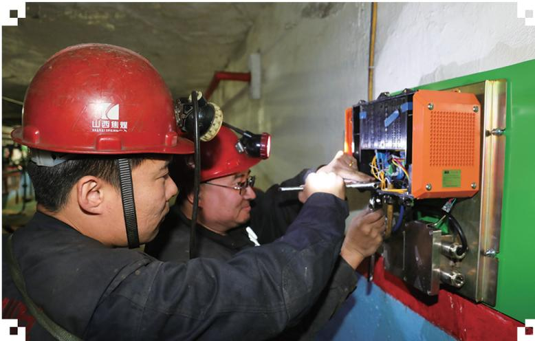
近日,水峪煤业信息中心以强化班组思想教育、加强员工技能培训、做好日常隐患排查为出发点,夯基础、强培训、抓管理,全力保障设备正常运行助力公司安全生产。图为该公司信息中心网络通讯队检修工正在对井下防爆扩播电话进行日常维护。
