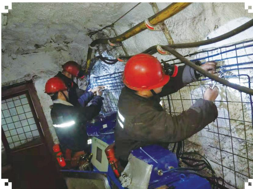
为扎实推进矿井安全生产标准化建设,积极营造安全生产环境,近日,两渡煤业井下维修队开展井下安全标准化创建工作,对第四、五部猴车硐室进行亮化美化工作,对电缆线路、挂钢筋网、控制线路进行重新排布,既美化了硐室,又方便了线路故障处理,保障了安全生产。该图为该队职工用钢丝绳对动力电缆进行排布。
