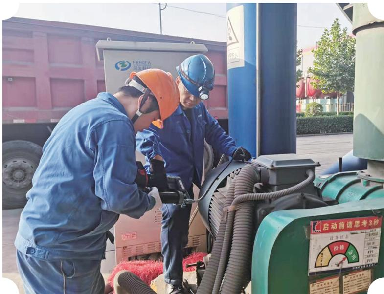
百日安全会战期间,发电厂为加强日常巡检和现场管理,认真落实主辅设备专管责任,强化设备包机巡检和维修保养制度的落实,不定期对电气设备进行保养,按照检修车间设备维护制度,对设备全面体检。当前,电气检修人员正在给3#炉内喷钙风机电机加油。
