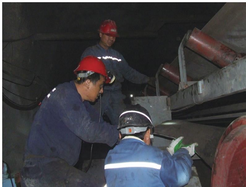
为保证18工作面输煤系统的稳定运行,近日,两渡煤业机运皮带队对二采区三一五三部皮带进行延长,经过11个小时的奋战,输煤皮带延长圆满完成,确保了安全生产的稳定运行。
