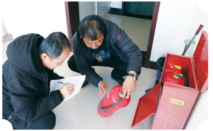
近日,瑞泰公司开展消防安全专项检查,重点检查两室一厅、地面库房、机房、值班门房、办公区、会议室等防火部位,灭火器是否完整好用,是否设置醒目的消防安全标识,消防器材使用是否熟悉等。对发现的安全隐患登记造册,列出整改清单,限定整改时间,坚决杜绝各类消防安全隐患,确保将隐患消灭在萌芽状态。
