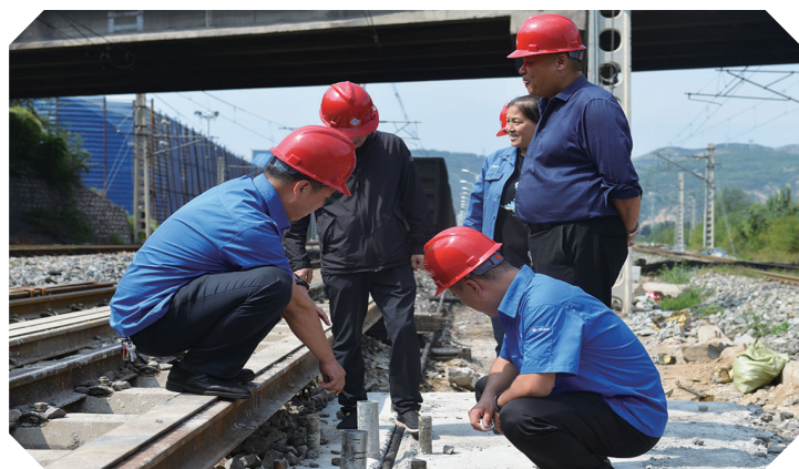
营运分公司迅速贯彻落实集团公司“百日安全会战”动员会议精神,把现场管理作为工作重点,推行“一线工作法”,领导干部带队到现场,抓安全、查隐患、查盲区、查死角,坚持横向到边、纵向到底、不留死角,对发现的隐患和不安全行为进行整改,保证运输安全和职工自身安全。 霍佳摄影报道
