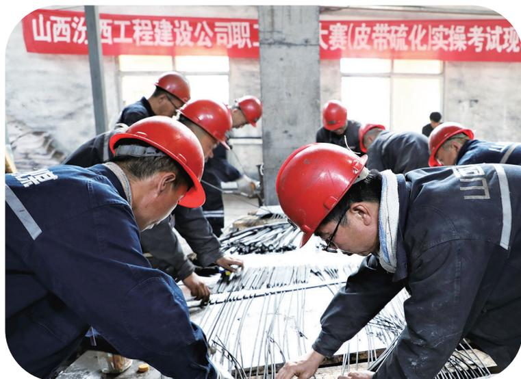
近日,工程建设公司首届职工技能大赛在正新公司和善煤矿举行,16人参加了皮带硫化比武。参赛选手赛出风格、赛出水平,力争取得最好的成绩。比武项目分为钢芯皮带拔头和硫化实操两部分。选手按标准程序将钢芯皮带完成拔头任务,并保证接头钢丝绳尺寸、接头角度、长度正确。硫化作业中,选手们需要掌握正确的硫化温度、硫化时间和硫化压力,参赛选手们全力投入、配合默契,按照要求完成每道工序。
