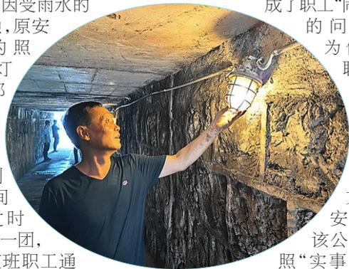
侵蚀,原装的照明灯大部分损坏,每到夜间通过时漆黑一团,给夜班职工通行带来了不便,同时也影响了职工家属夜间出行安全。该公司按照“实事求是”的原则,要求机电部门人员对巷洞照明线路进行了详细的检查。经排查,照明线路和灯泡存在不同程度的损坏。随后,维修人员对损坏的线路进行了修理,并将灯泡全部更换。经过4个小时的作业,“失明”巷洞恢复照明,职工家属夜间出行也有了安全保障。
