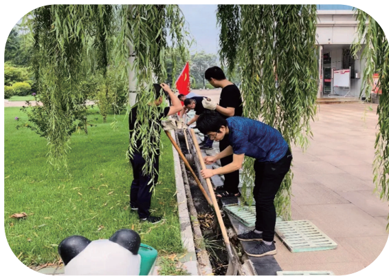
日前,曙光煤矿团员志愿者雨后对矿区道路两侧的排水沟渠再次进行排查清掏。此项工作将作为该矿常规工作,每次雨后会对排水渠进行检查,及时解决,确保排水畅通。褚晓明摄影报道
