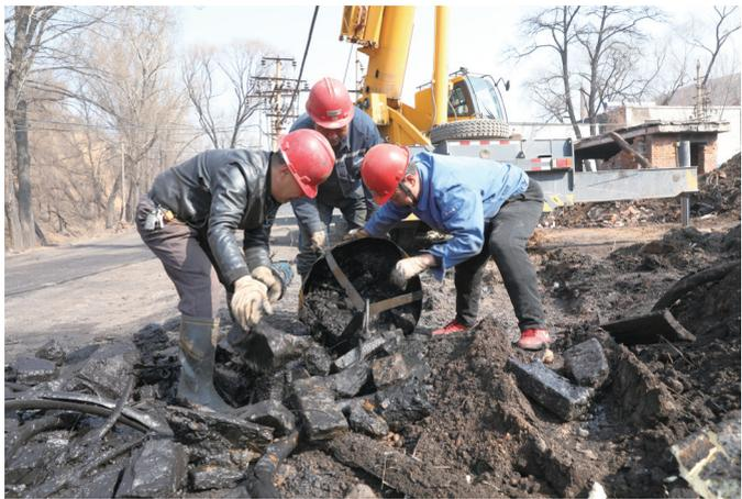
近日,生活服务公司柳湾管理中心组织人员对五号地区原废弃水井进行清挖修复工作。在清挖完成后,还将对水井上方加装顶盖,并对井底采取撒石灰等方式进行消毒,进一步保障水质达标,确保矿井生产用水。
