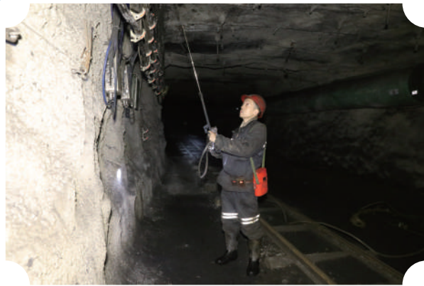
自进入汛期以来,柳湾煤矿在扎实做好地测防治水工作的基础上,进一步加大“一通三防”专项整治力度,持续加强重点巷道、关键区域的氧气浓度及瓦斯和其他有害气体的检测监控,全力确保安全生产。图为通风区瓦检员正在检测掘进巷道回风流流的瓦斯浓度。
