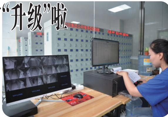
存、取时间信息自动录入电脑。智能矿灯充电架输入电压范围宽,输出电压稳定。充电状态采用发光管指示,指示明显,整机输入电压电流,输出电压电流均有数字表指示,便于职工观察使用。(侯世恩)
