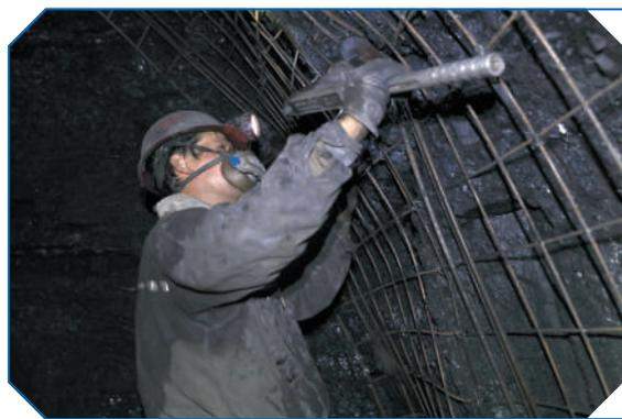
柳湾煤矿复工复产以来,高度重视安全工作,近日组织开展顶板管理专项治理活动,要求作业人员严格按照规程对巷道内所有锚索锚杆进行加固,确保顶板支护有效。图为矿掘进准备队职工正在对锚杆进行加固。
