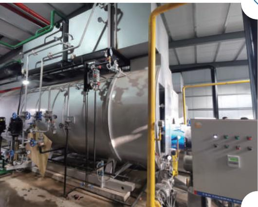
近日,正令煤业锅炉房正式完成改造举行点火仪式。该公司按照环保要求将原有燃煤粉锅炉更换为全自动燃气冷凝蒸汽锅炉,在满足环保要求的同时,大大提高了供热效果。该公司要求加强供暖人员岗位值守,做好锅炉设备的日常检修维护,确保系统能够正常稳定运行,为矿井安全生产保驾护航。白波 摄影报道
